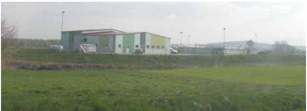
Slika 55: Obstoječa centralna čistilna naprava Brežice 500 m od Mosteca
