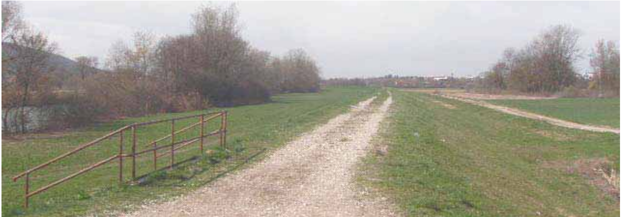
Slika 53: Obstoječi visokovodni nasipi pri Mostecu s pogledom na Brežice
